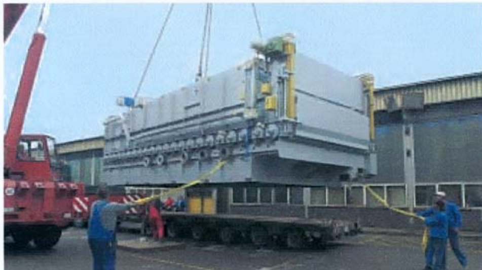
Zehn Meter lang, fünf Meter breit, fünf Meter hoch und mehr als 40 Tonnen schwer: Der erste Teil des neuen Glühofens bei FAG Kugelfischer in Schweinfurt schwebt ein.
